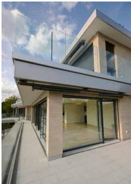
Bordi di soletta precisi con il cassero BEGO®. Si tratta di un cassero a perdere per bordi di soletta in cemento armato. Non ci sono più rilavorazioni o finiture del cemento armato! Tutti i lavori di scasseratura sono eliminati.
