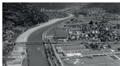
Vista dell'autostrada in costruzione e del Bagno di Bellinzona portato a termine da poco (la passerella verrà completata l'anno successivo con la discesa verso la diga), 11 luglio 1970. Zurigo, ETH-Bibliothek, Bildarchiv / Fotograf: Comet Photo AG (Zürich) / Com_F70-18102 / CC BY-SA 4.0
