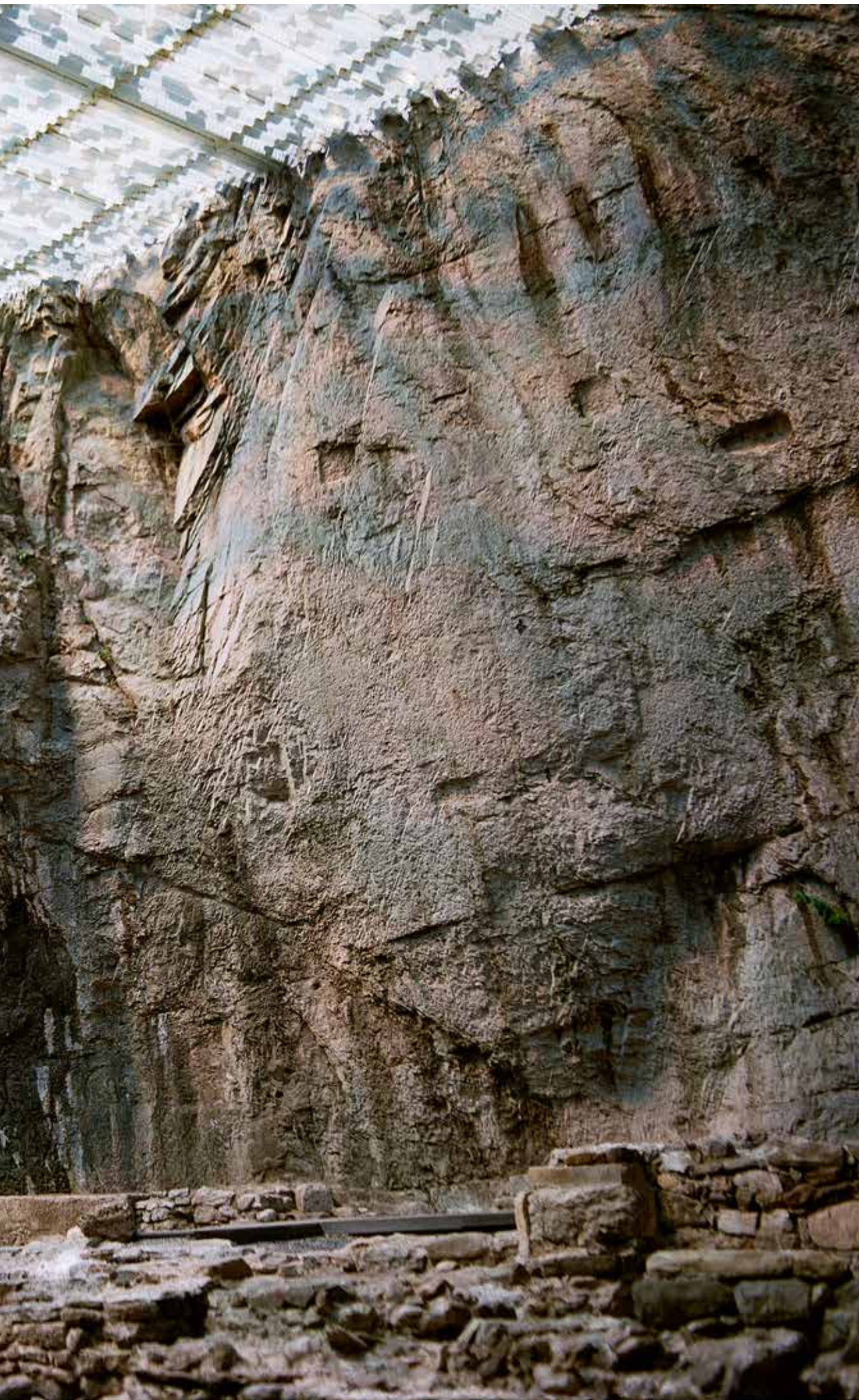
3 Überdachung der Ruinen von Saint-Maurice VS | Couverture des ruines archéologiques, Saint-Maurice VS | Coperte le rovine archeologiche di Saint-Maurice VS
